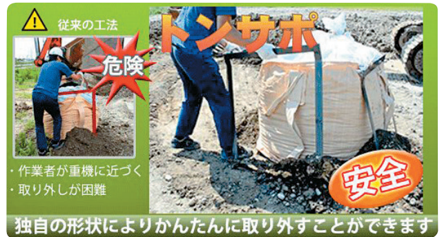
③展開箇所の金具、羽根を外し、片方ずつ外す
