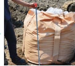
④大型土のうの完成
