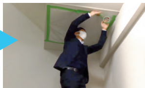
②シートで水漏れ箇所を覆い、専用テープで貼り付けます
