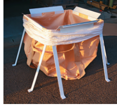
②大型土のう袋、羽根、接続金具を取り付け土砂を投入
